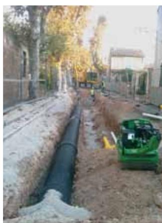
Enfouissement des réseaux électriques et téléphoniques. Prévision des réseaux gaz et rénovation de tous les réseaux d'assainissement
