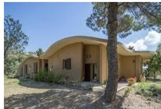
Les trois bâtiments sont construits selon le même principe d'une "succession d'envoûtements sous quoi sont les maisons" : les pièces sont couvertes par une voûte d'un seul tenant, faisant office de paroi et de toit, formant une courbe harmonieuse et adaptée au Mistral.
