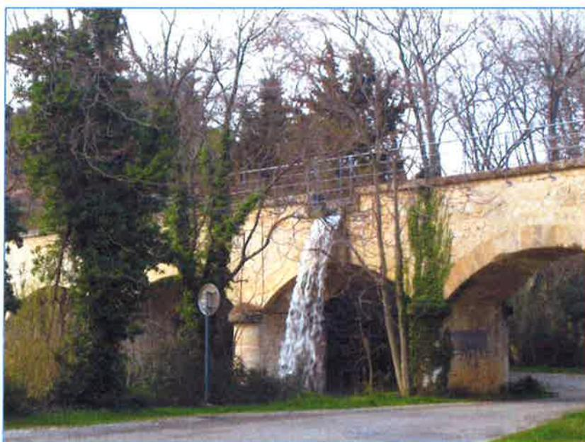
Figure 3: Canal d'irrigation de la vallée des Baux avec surverse vers la gaudre du Tribble (Photo du 17-03-2016)
